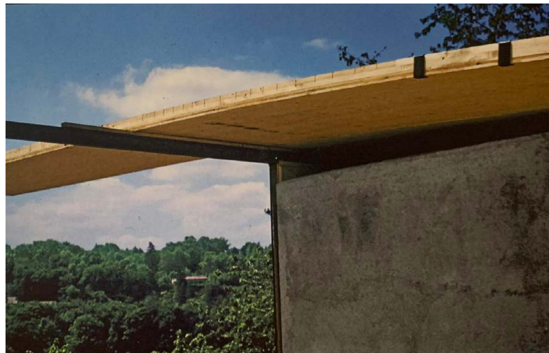
flexibele houten panelen als dakversteving.
