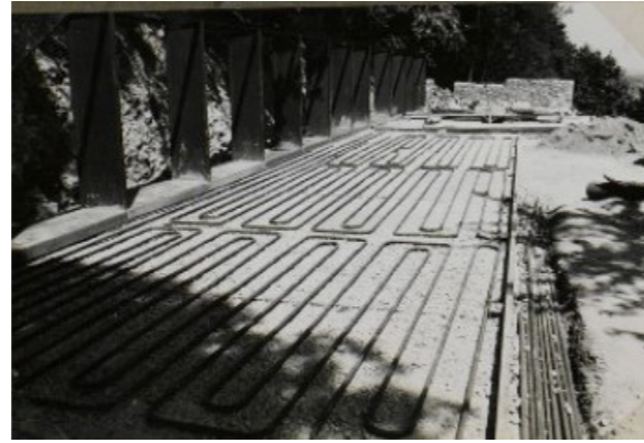
1 JUNI 1954 MONTAGE VAN DE GEPREFABRICEERDE ELEMENTEN EN HET DAK
