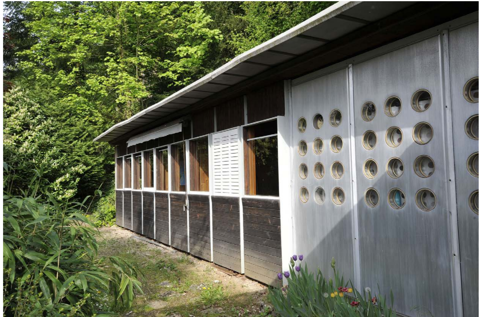
zuidgevel met patrijspooten en verticale schuiframen.
